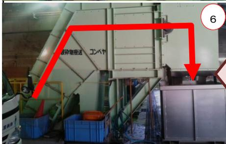
6 矢印の方向へずっと行くと、右下にある箱(小さいコンテナボックス)になってます。)にゴミが貯められて行きます。
